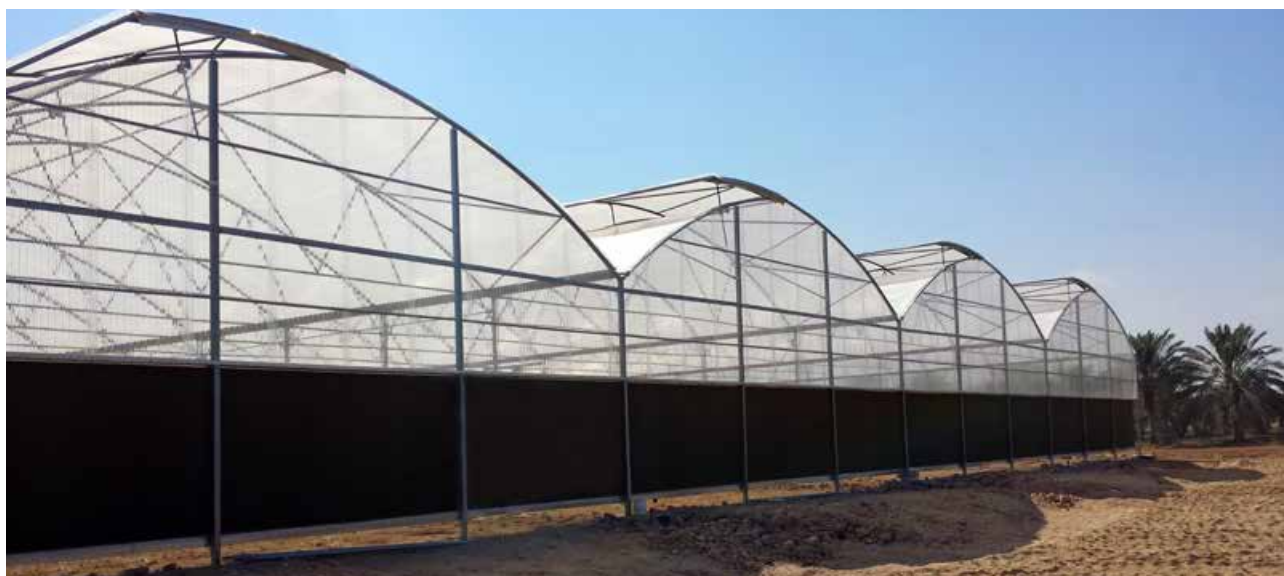
Impianti di raffrescamento / Cooling system / Installation de refroidissement
